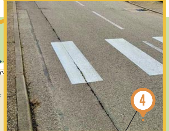
Marquage au sol passage piéton, chemin de Trembas
