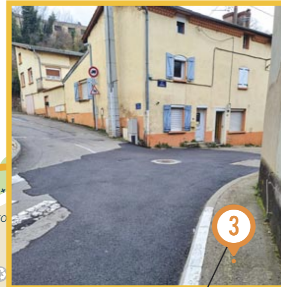
Réfection d'enrobé de la voirie, rue de la Convention
